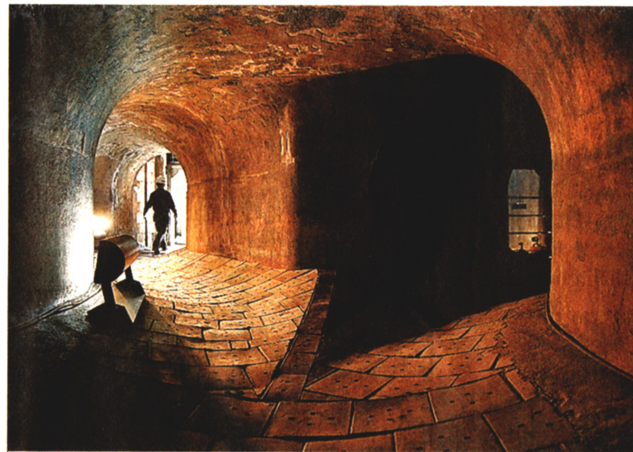
かつて下水が流れた地下トンネル。床には陶板が張られている=26日、東京都荒川区
