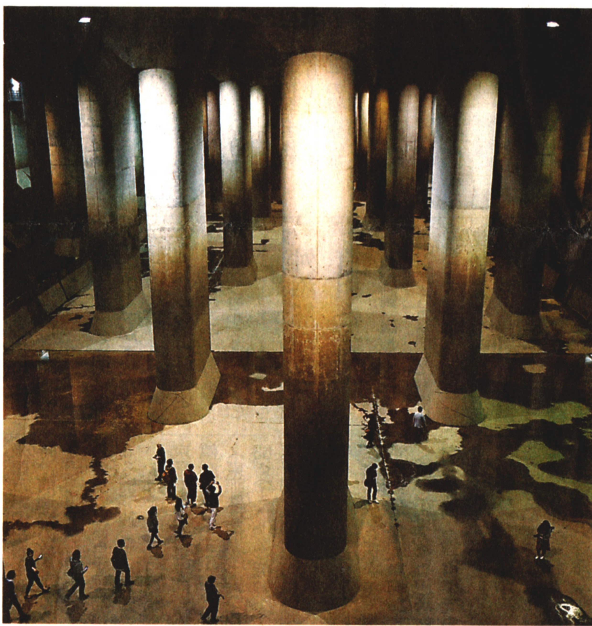
神殿のように柱が並ぶ「調圧水槽」を見学する人々=25日、埼玉県春日部市
